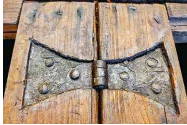
8. Dettaglio di una cerniera metallica del telaio
