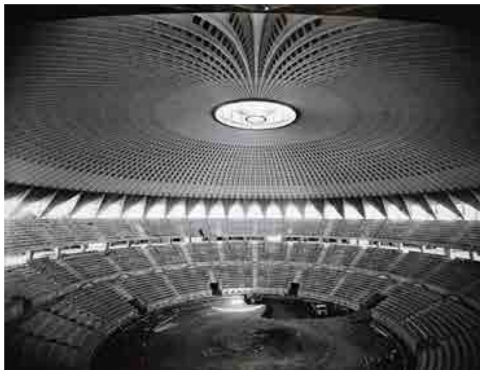
Fig.32_Ammirato e ineguagliato mix di estetica, funzionalità ed economicità (strutturale, di costi, di tempi di realizzazione e impiego di materiale). Divenuto celebre durante le Olimpiadi di Roma del 1960, il Palazzetto è emblematico della «seconda vita» di Nervi, quella del dopoguerra, incentrata sulla sperimentazione del ferrocemento e della prefabbricazione strutturale.
