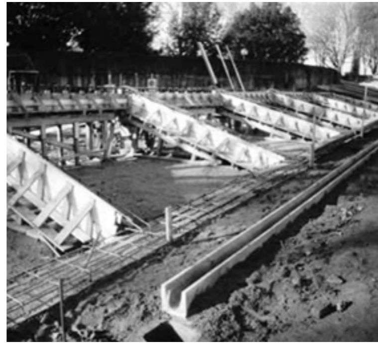
Fig._ Nel 2002 in occasione dei lavori di riqualificazione degli impianti dedicati al ciclismo per i Mondiali di Ciclismo del 2004 con arrivo a Firenze, il velodromo delle Cascine ha visto la ricostruzione della pista con demolizione e ricostruzione del manto.
