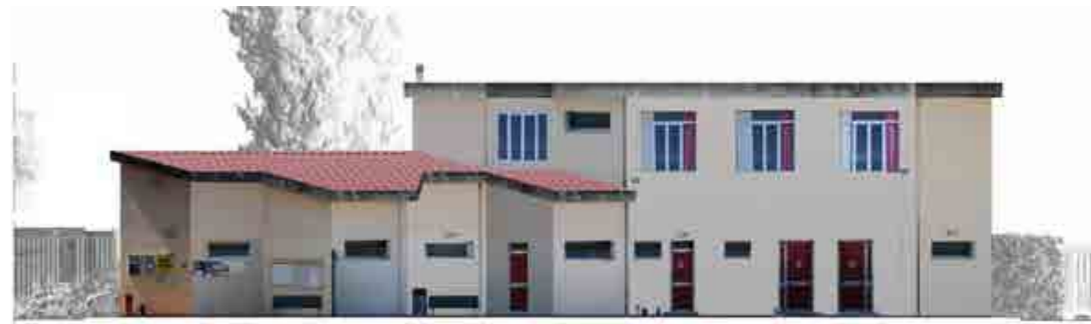
In fig._ Ortofoto del fronte principale degli spogliatoi
