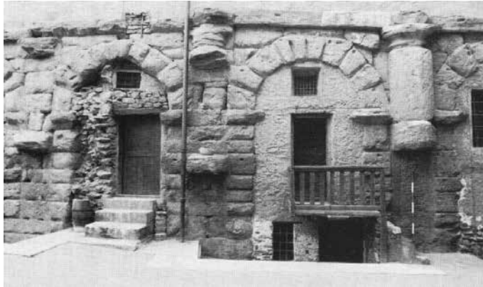
Figura 43. Aosta. Particolare della facciata (foto Autore).
