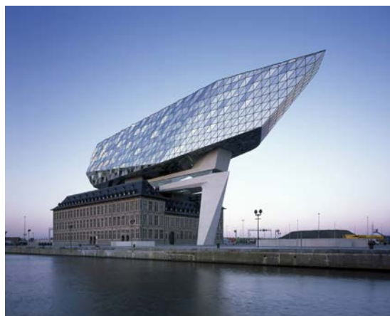
Fig. 421: Zaha Hadid Architects, New Port House, 2016, Antwerp, Belgio. Progetto per la conversione di una vecchia stazione dei pompieri in nuovo hub portuale.
