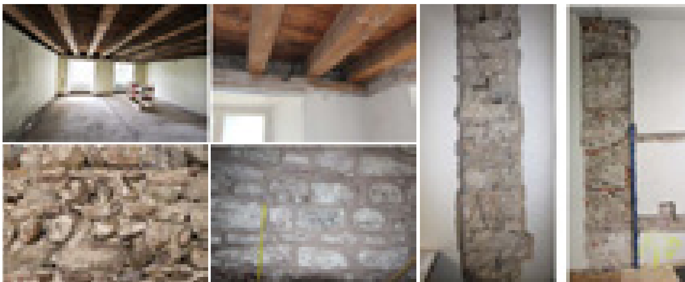
Caratteri principali delle tipologie costruttive applicate nelle strutture storiche: (6.14-6.15) diaframmi di solaio ligneo ad orditura longitudinale, (6.16-6.17) tessiture murarie in blocchi di pietra squadrati o miste con ciottoli di fiume; (6.18-6.19) sondaggi sulla stratificazione e tessitura muraria eseguiti in alcune unità del centro storico dai ricercatori dell'École Polytechnique Fédérale de Lausanne.
