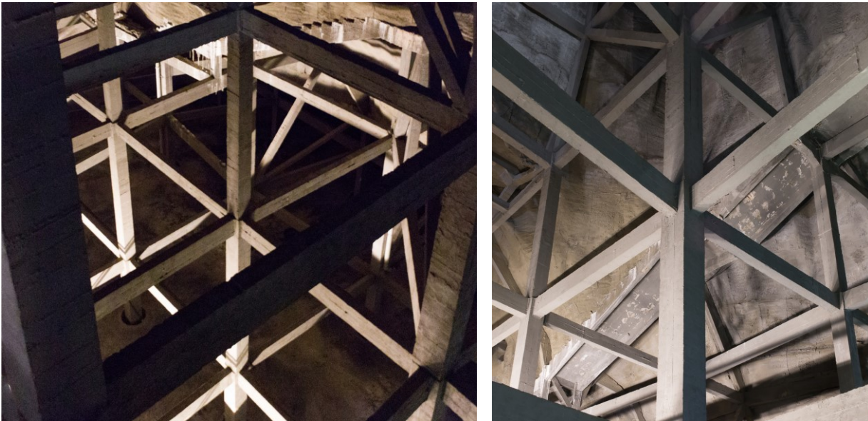
Grand Rocher, trama di travi e pilastri e spazio cubico. Foto di Antoine Espinasse.
