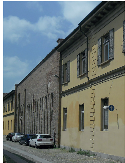
Fig. 117. Vista del prospetto su Via San Felice al Monastero. Si noti la parte ottocentesca, finita in intonaco, accostata alla chiesa in muratura facciavista. Fonte: Archivio fotografico di Ateneo.
