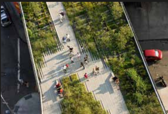
Vista dall'alto della High Line FONTE: dsrny.com/
